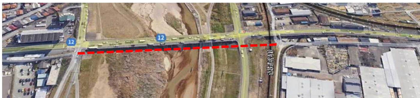
2021.02.10 Google Earth（北から）
