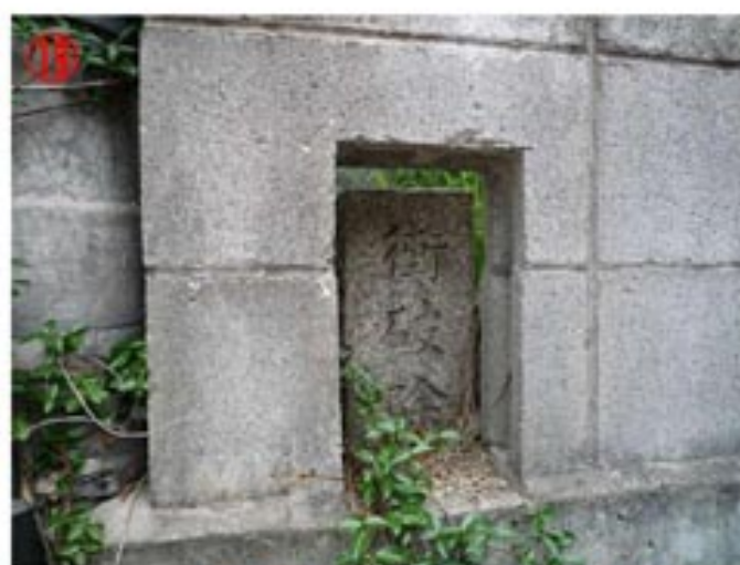
羽曳野市碓井(ブロック塀に守られてよくぞ残った)
