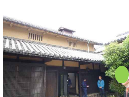
棧瓦葺・煙り抜き
